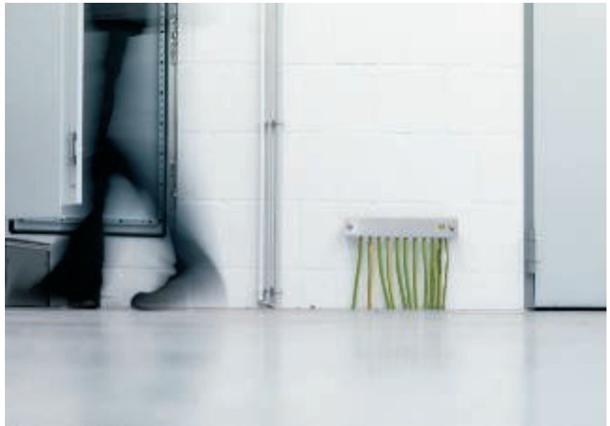
Сверху: комбинированный разрядник в распределительном шкафу. Внизу: шина уравнивания потенциалов. Справа: молниеприемная мачта.
