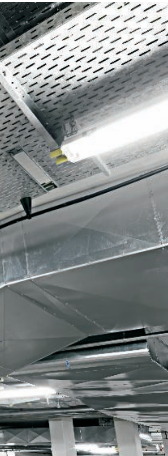
Справа по центру: система листовых лотков RKS-Magic®. Внизу: система листовых лотков MKS- Magic®.
