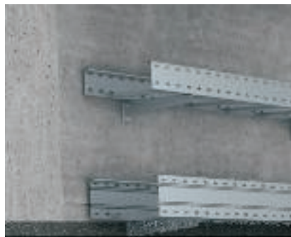
Настенный монтаж Прямой настенный монтаж систем кабельных лотков для больших расстояний.
