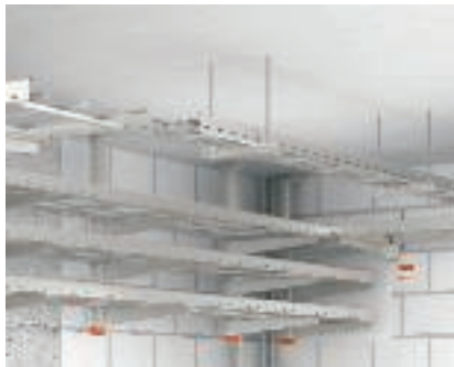
Комплексный монтаж системы кабельных лотков Потолочный монтаж многоуровневой системы кабельных лотков.
