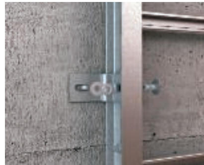
Крепление вертикального кабельного лотка лестничного типа промышленного исполнения Настенное крепление вертикального кабельного лотка лестничного типа промышленного исполнения осуществляется с помощью крепежных уголков BW80/55.
