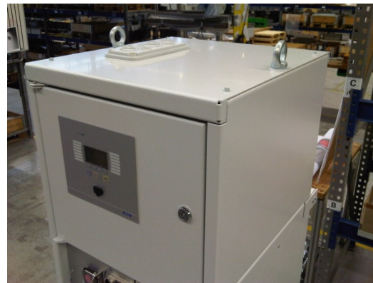
Рис. 3-1. Подъёмные кольца на одиночной ячейке
